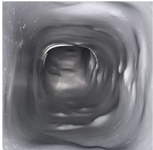
Tegelkanal efter tätning med Linervent
