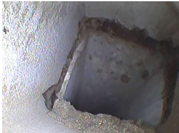
Eternitkanal med väl synliga hålsador
