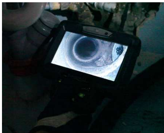
Granskning med inspektionskamera
