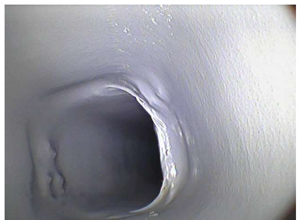
Eternitkanal efter tätning med Linervent
